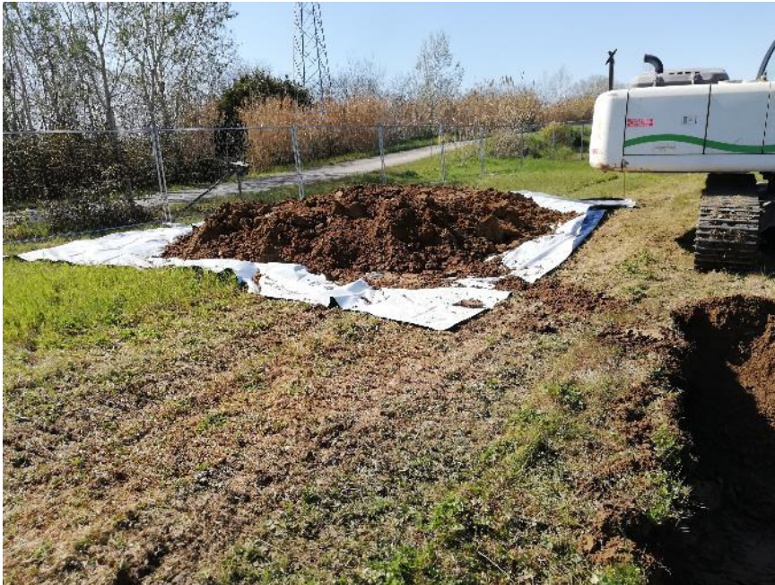
Foto 2 – TERRENI SU TELO IN HDPE E RECINZIONE DI CANTIERE
