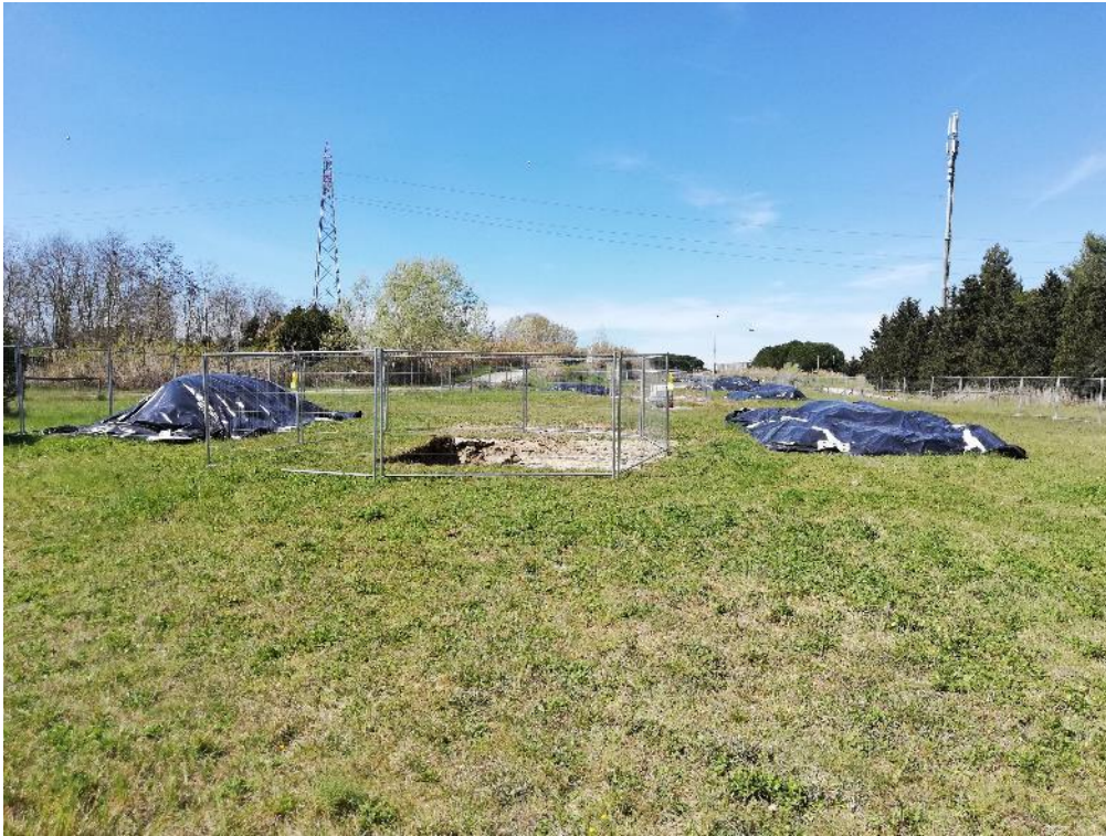
Foto 3 – TERRENI COPERTI DA TELO IN HDPE E SCAVI CON RECINZIONE.
