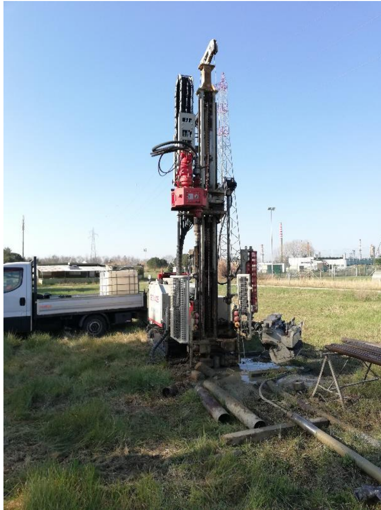
Foto 6 – SONDA PER ESECUZIONE DI PIEZOMETRI
