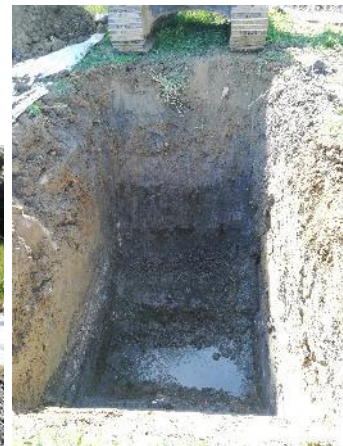
S12- presenza di ghiaia di riporto scura nel cumulo profondo
