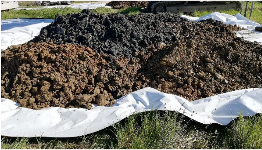
Foto 1 – TERRENI SU TELO IN HDPE
