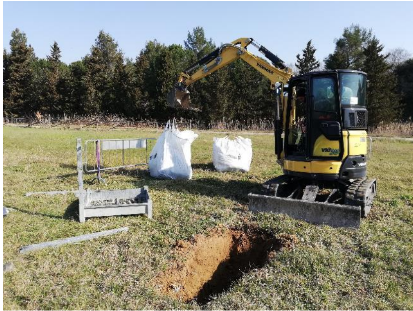
Foto 4 – SCAVO PER VERIFICA SOTTOSERVIZI ED INSERIMENTO DEI TERRENI ALL'INTERNO DI BIG BAGS
