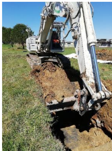
S13- operazioni di scavo
